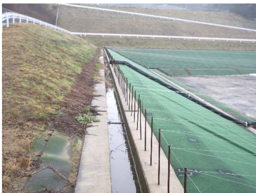
(周辺部集排水溝)
