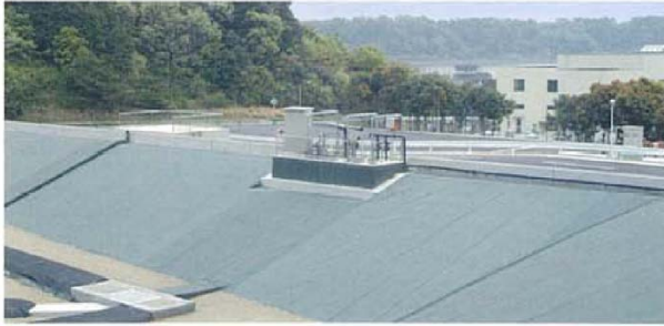
(盛土ダム 土堰堤)
