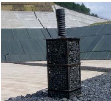
(堅形ガス抜き設備)
