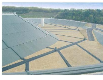
(底部集排水管、法面排水管)
