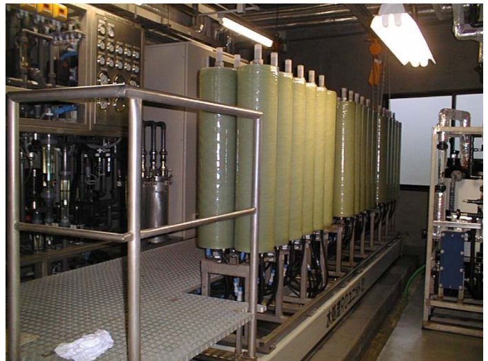
(逆浸透法による脱塩処理設備)
