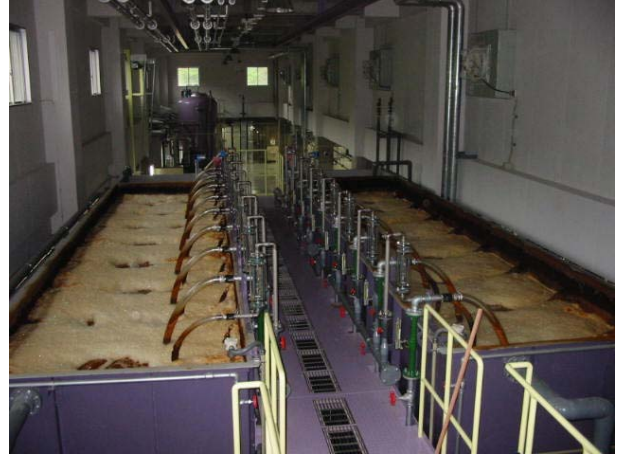
(凝集膜ろ過設備)
