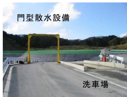
図 7-8 散水設備の設置例
