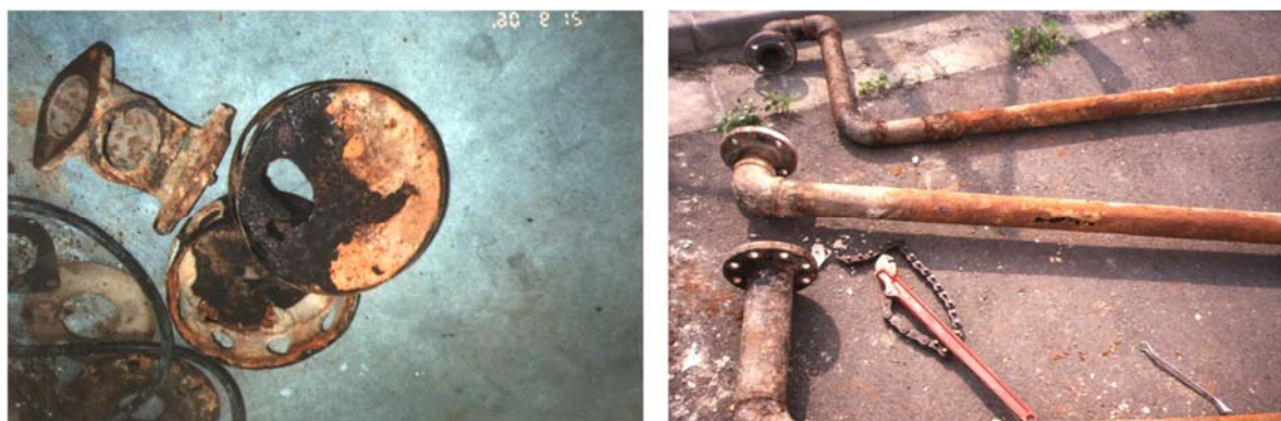
図 5-7 浸出水処理施設の機器類、配管の腐食事例
