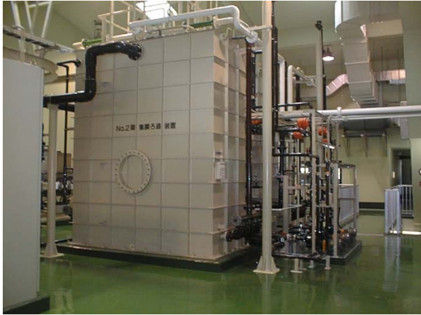
(凝集膜ろ過設備)
