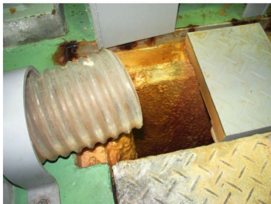
A処分場浸出水処理施設凝集槽内
