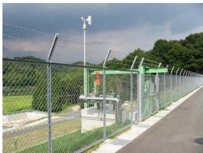
図 7-7 風向・風速計の設置例
