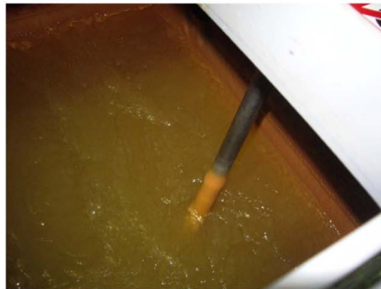
A処分場浸出水処理施設凝集槽攪拌機シャフト
