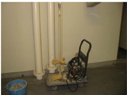
B処分場浸出水処理施設凝集槽攪拌機シャフト
