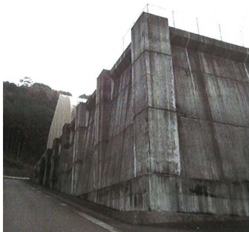
(コンクリートピット)
