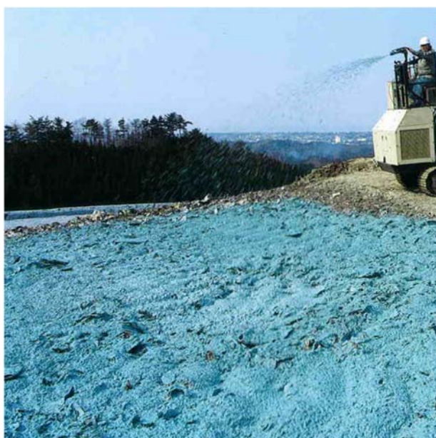
図 3-4 生分解性材料を用いた即日覆土の例
