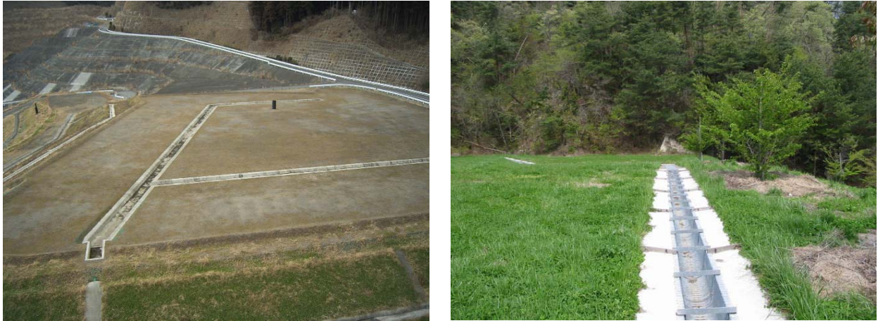
図 8-2 埋立終了面の表面排除の事例
