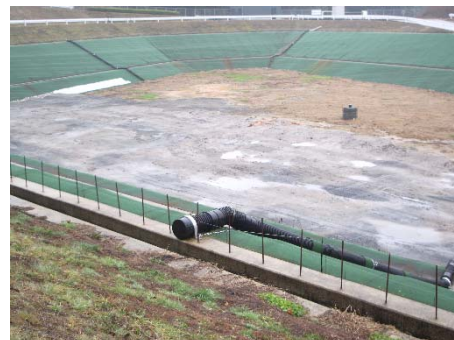
(法面ガス抜き設備)
