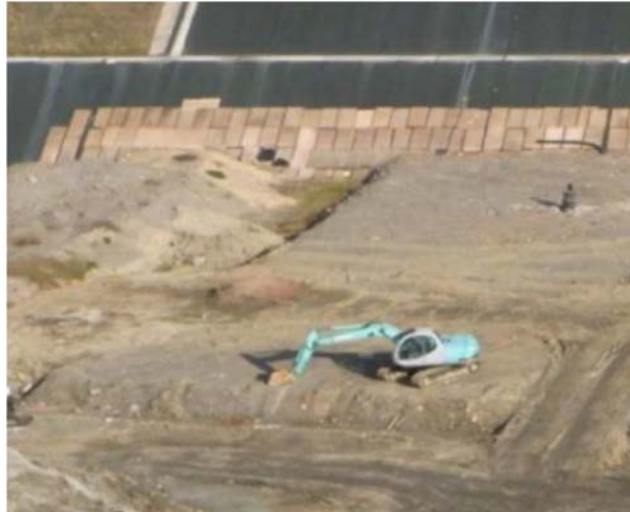
図 6-16 量によるシート保護の例
