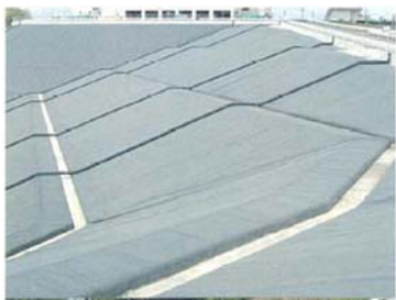
(法面集排水管)
